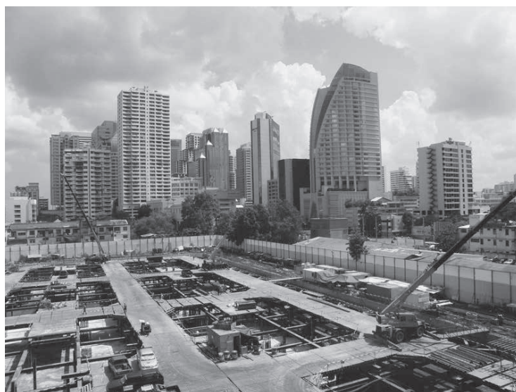
タイのビル群と建設現場
