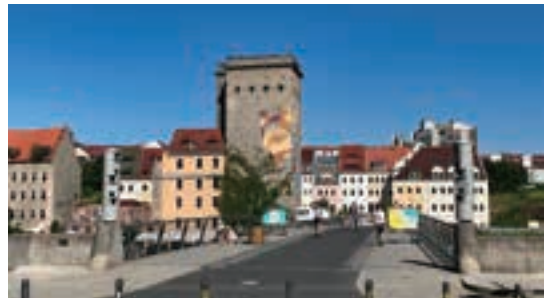
ドイツ側から橋を撮ったもの。橋の両側の物々しい監視カメラが印象的
