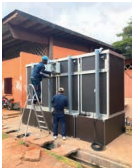
JICA「中小企業・SDGs ビジネス支援事業～普及・実証事業～」で、バイオトイレ4台を国立ヤウンデ第一大学に設置（その他の場所も含め合計16台を設置、現在も稼働中）
